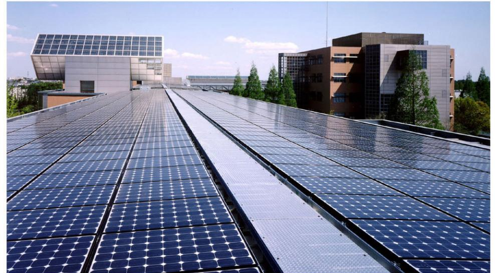
ソーラーパネル 300KW+ ソーラーチューブ 11KW
